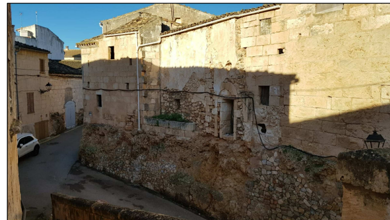
VISTA FACHADA (ESTADO ACTUAL)
