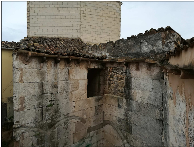
VISTA PATIO (ESTADO ACTUAL)
